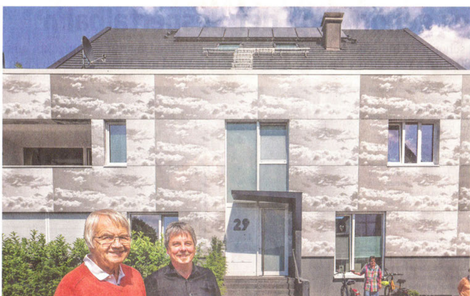
Der Eigentümer des „Wolkenheims“, Reiner Gravius (li.), und Joachim Schepers vom Architekturbüro Kenchiku.
