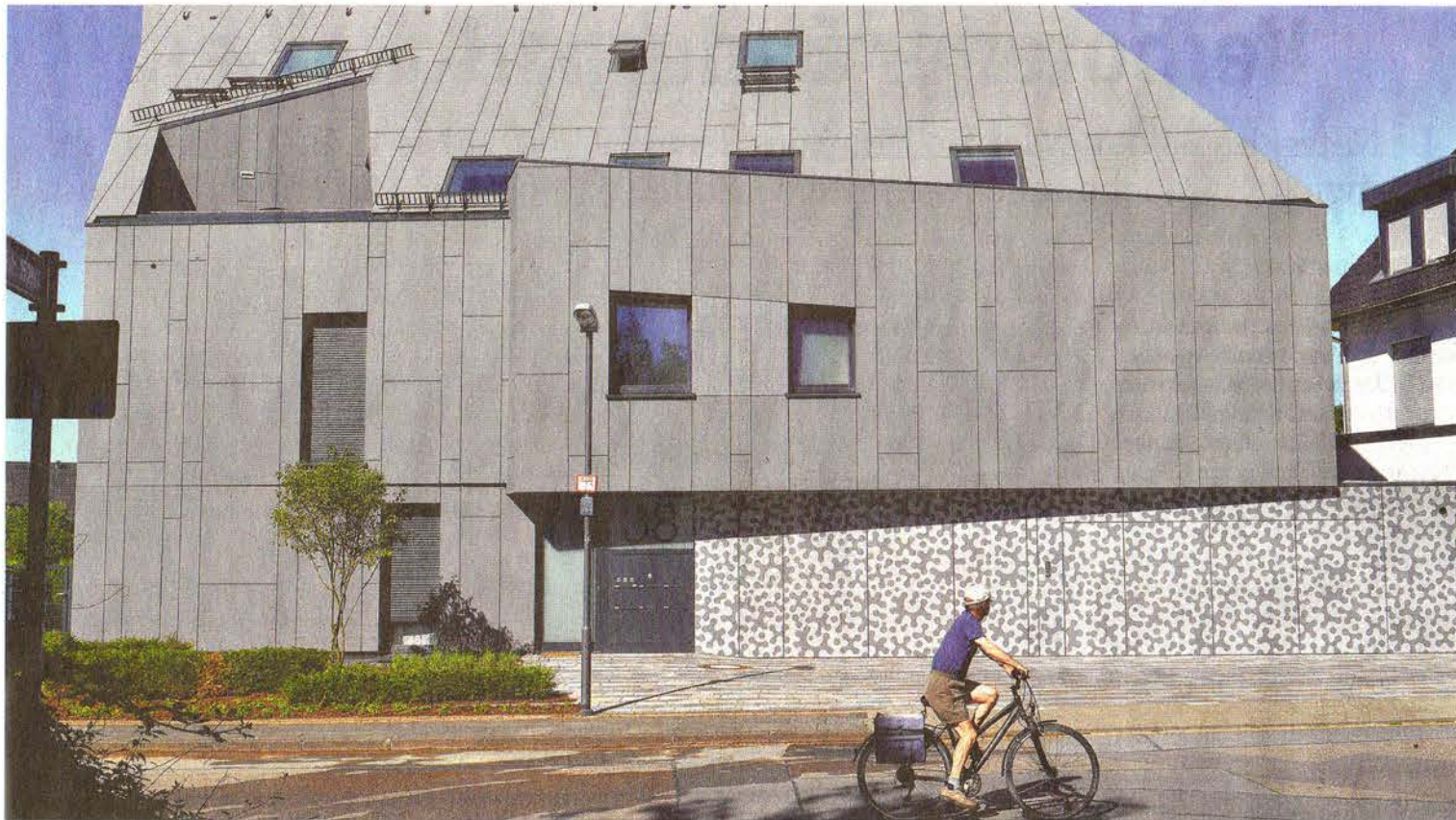
Beeindruckend: Der „Anthrazit“, ein Mehrfamilienhaus an der Roßstraße 38, kann am Sonntag zum Tag der Architektur besichtigt werden.
